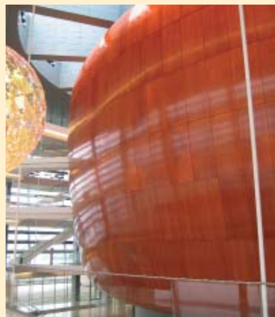
Prachtig gebogen brandvertragend MDF in de Opera te Kopenhagen; ontwerp: Henning Larsens Tegnedstue Kopenhagen.
