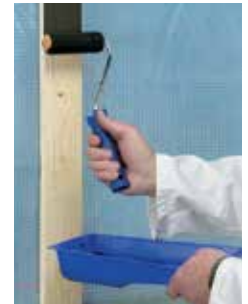
Voorbehandeling houten draagconstructie met Primer SX Black
